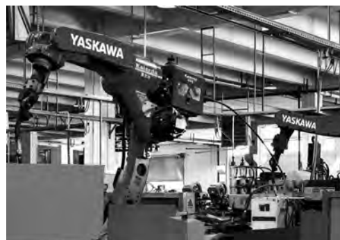
Автоматизована зварювальна лінія
